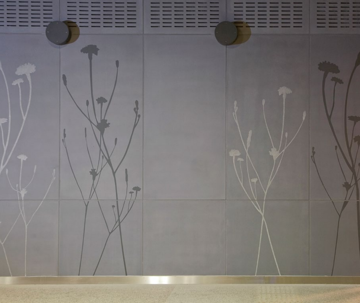
4-es metró tűzgátló design beton burkolata, Budapest | Alkalmazott szál típusa: Multi műszál 12,7 mm
