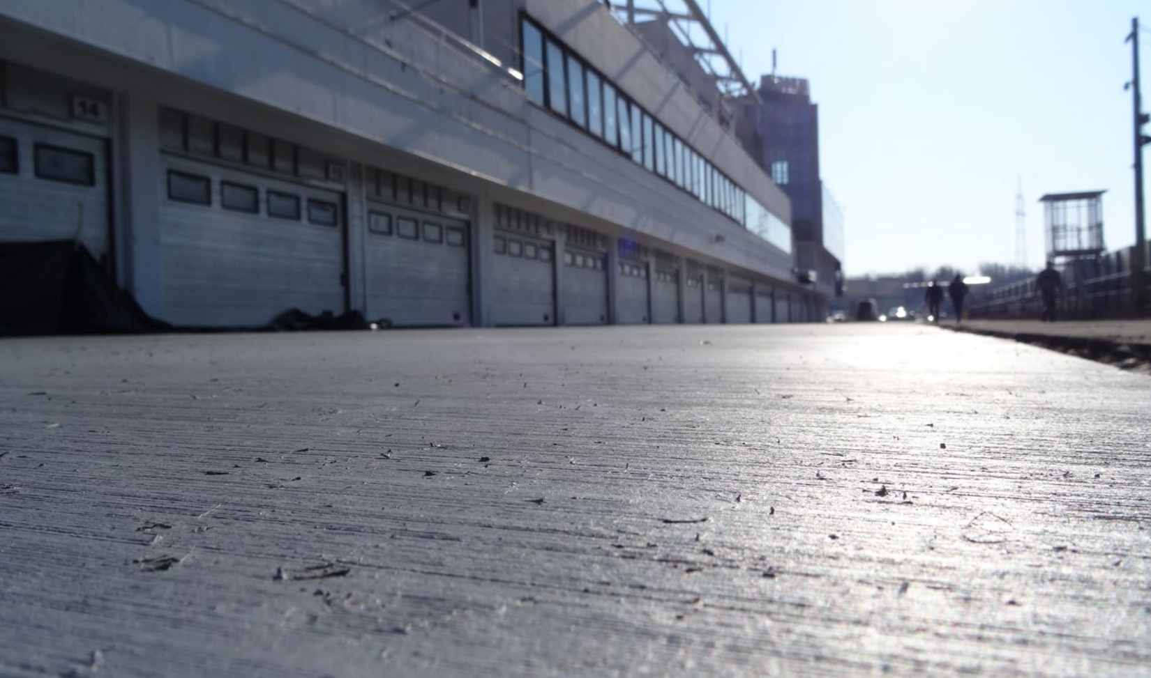
Hungaroring boxutca, Mogyoród | Alkalmazott szál típusa: High Grade fibrillált műszál 19 mm
